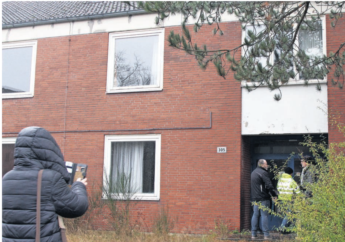
Die Gebäudesubstanz in der Altenwalder Kaserne (hier bei einer Begehung Ende 2022) wird jetzt genauer untersucht. Die Ertüchtigung wird einiges an Zeit in Anspruch nehmen. Foto: Reese-Winne
