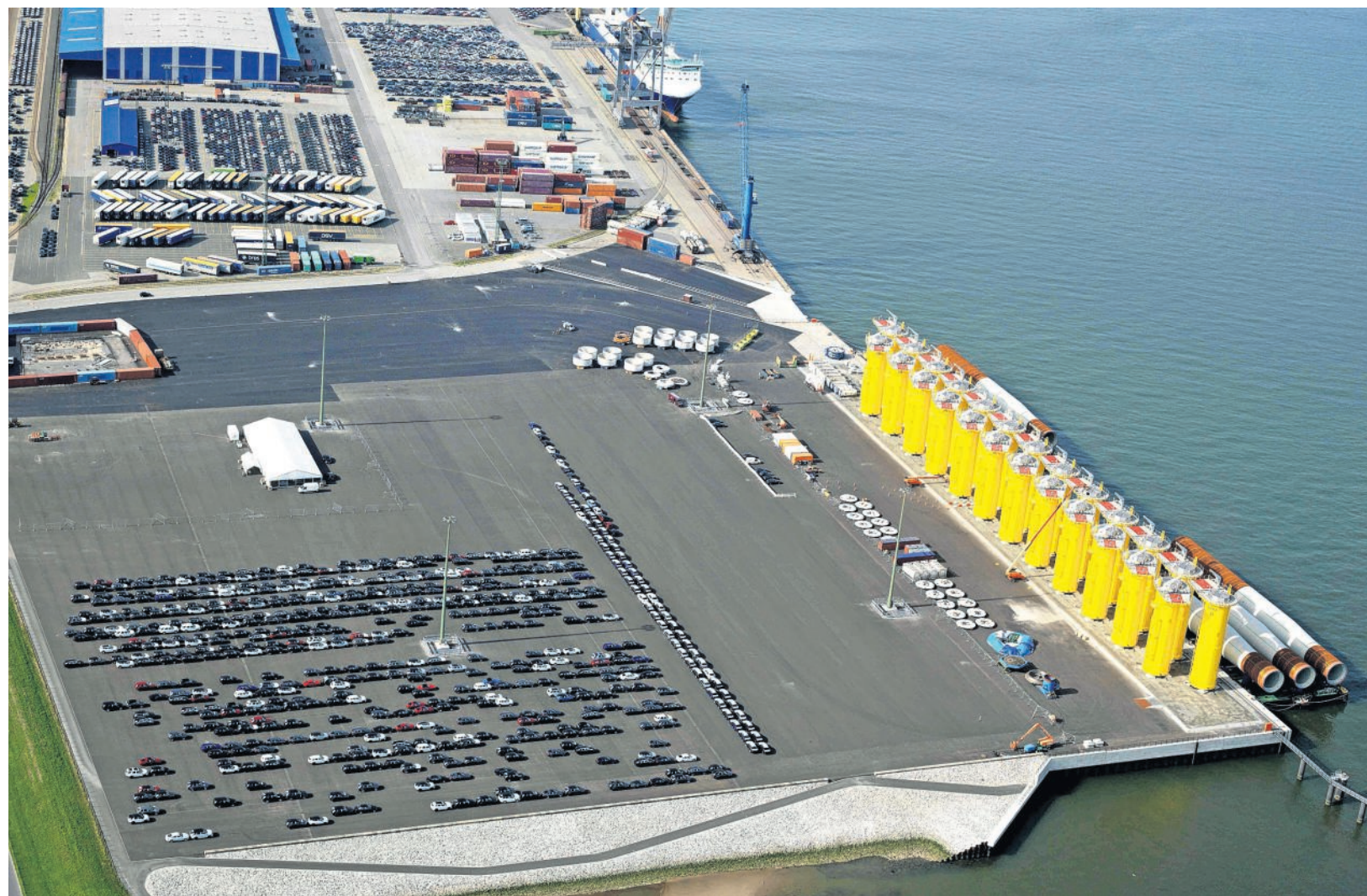
Umschlag von Offshore-Komponenten in Cuxhaven. Die Luftaufnahme zeigt den 2018 eingeweihten Liegeplatz 4. Archivfoto: Scheer
