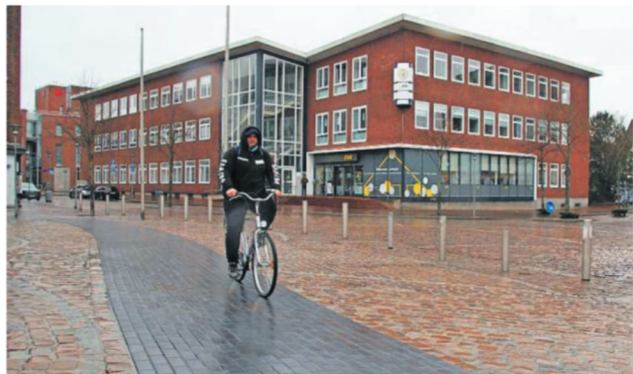
Ab sofort können Fahrradfahrer holperfrei über den Kaemmererplatz fahren. Der neue Weg wurde aus anthrazitfarbenem Klinker verlegt.
