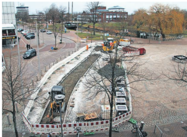
Vor ein paar Tagen wurde noch an dem Radweg gebaut. Das alte Pflaster wurde entsorgt , weil es mit Betonresten versetzt war. Fotos: Potschka
