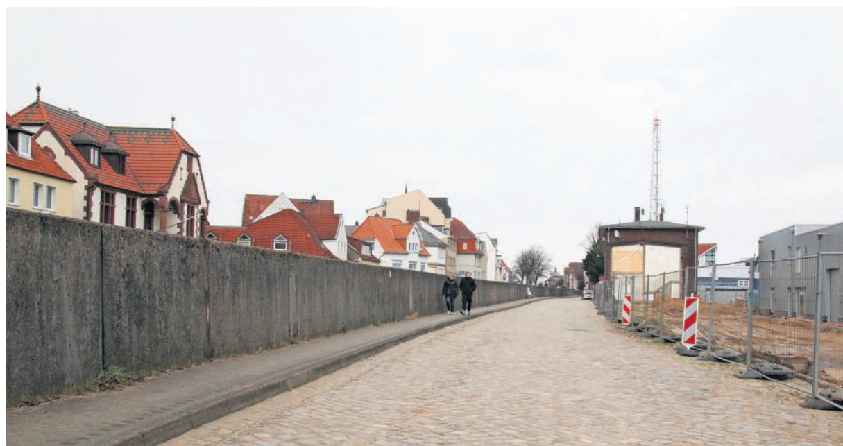
Von der Straße Am Schleusenpriel aus gesehen wirkt die alte Flutschutzmauer noch unansehnlicher: Der Blick vom NPorts-Gebäude aus erinnert viele Cuxhavener und Gäste an ein „triste Betonwüste“.
