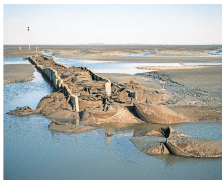
2019 baute das NLWKN Big Packs , mit Sand gefüllte Säcke, als Barriere ein, um den Priel zu unterbrechen und eine weitere Vertiefung verhindern. Die Maßnahme hat sich allerdings als Fehlschlag erwiesen. Archivfoto: Assanmoghadam / dpa
